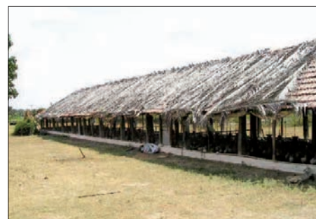
Toitures avec branches de palmiers
