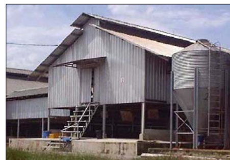
Toiture avec lanterneaux
